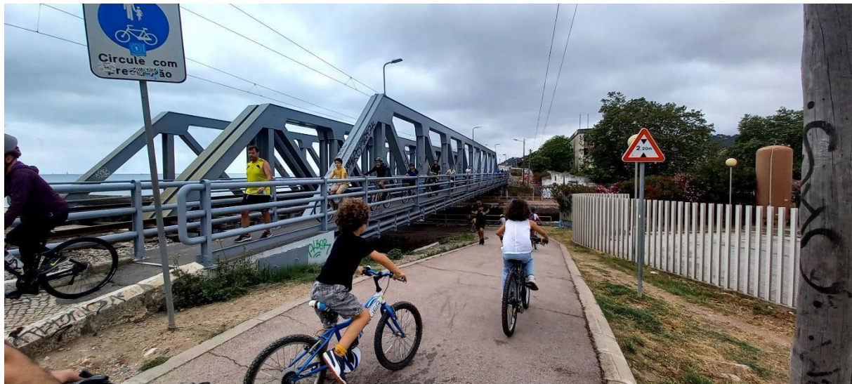
Imagem 3 – Ponte muito estreita sobre o Jamor: acesso à estação da Cruz Quebrada (Ciclovía na Marginal)
